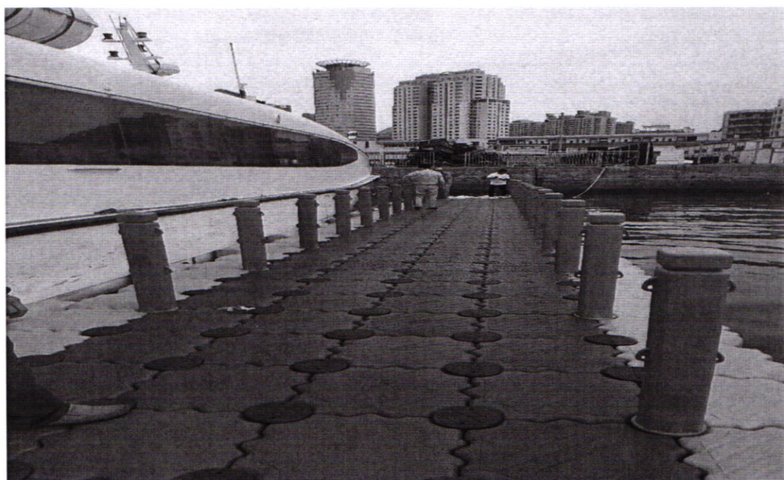
(五) 新建设的浮排（浮排护栏正在完善中）
