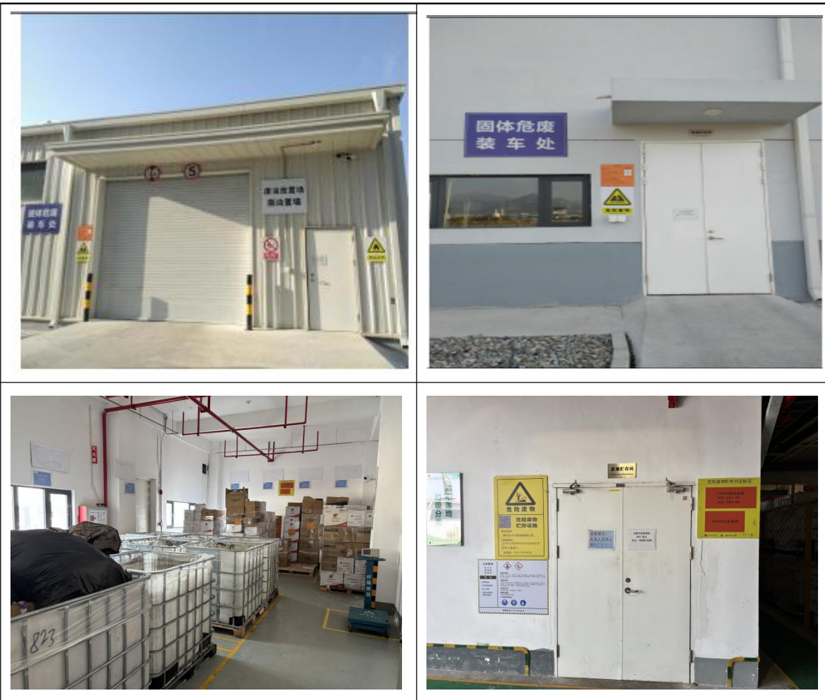
图14 危废间现场照片
