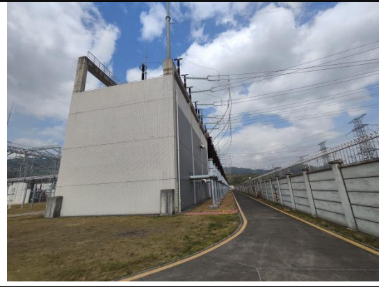
220kV 配电装置楼
