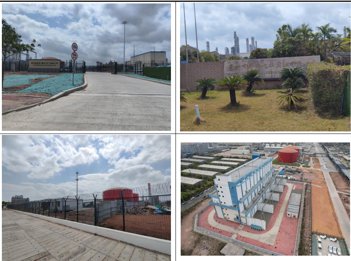
220kV 伟业站周围环境现状
