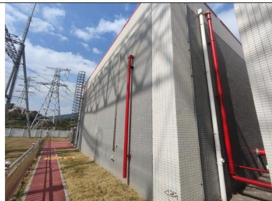
消防水池及消防泵房
