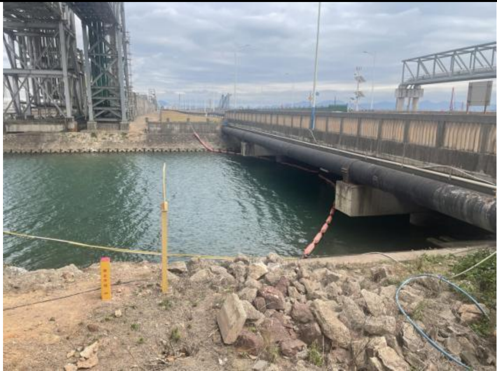
管廊穿越岩前河
