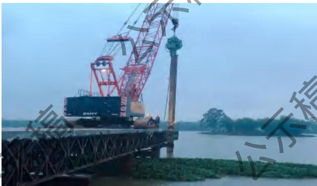
图 3.3-7 钢管桩沉桩施工示意图
