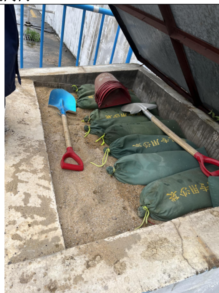
库区外沙池、沙袋等应急封堵照片
