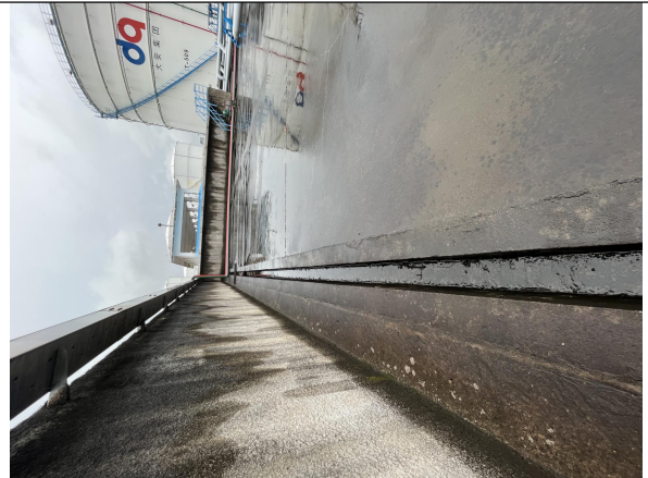
防火提内雨水管网
