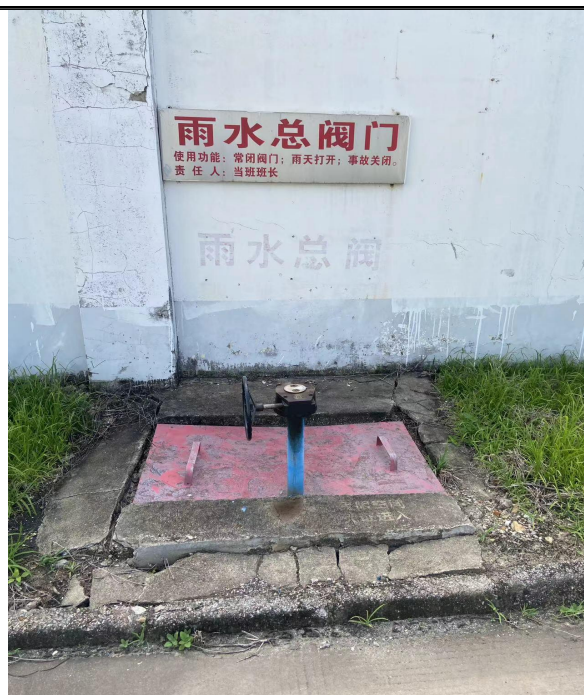
雨水检测池及切换阀门
