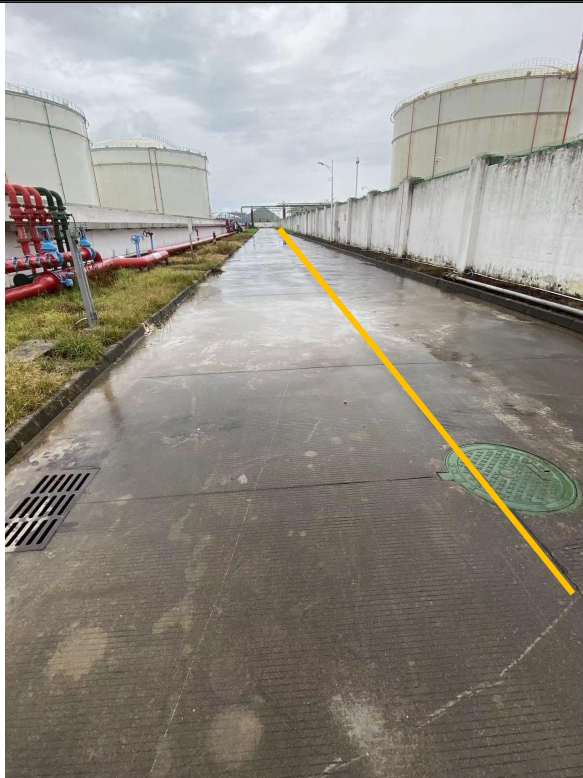
防火堤外雨水管网
