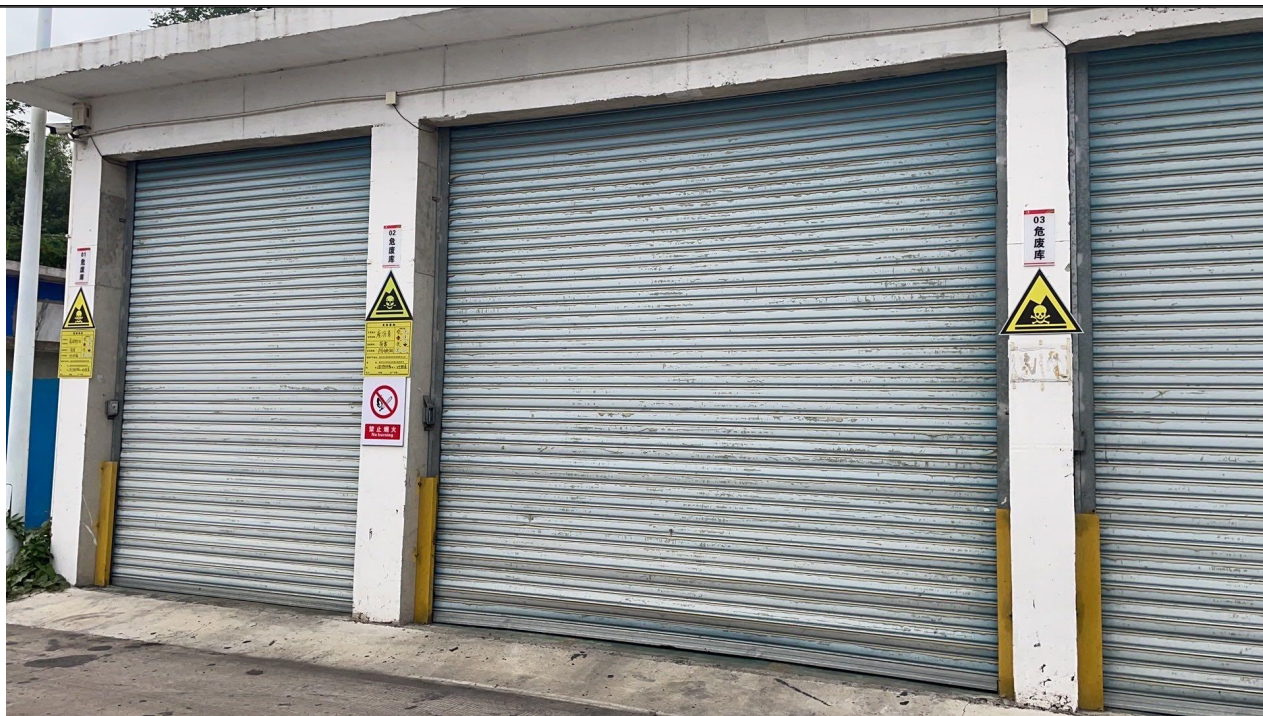
危险废物贮存库
